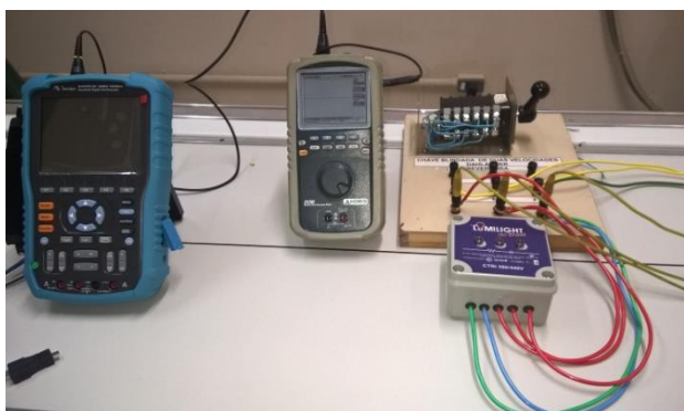
Figura 2 – Montagem experimental para monitoração da rede elétrica.
